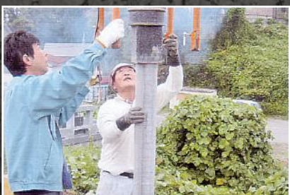
パイルの打ち込み
