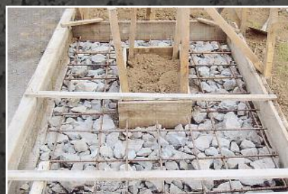
鉄筋の組み立て
